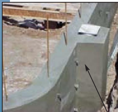
Filtre de surface coulé sur place
