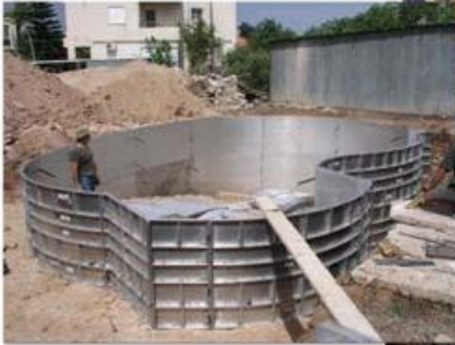
Piscine en béton
