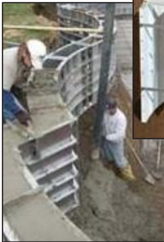
Coulage du sol en béton
