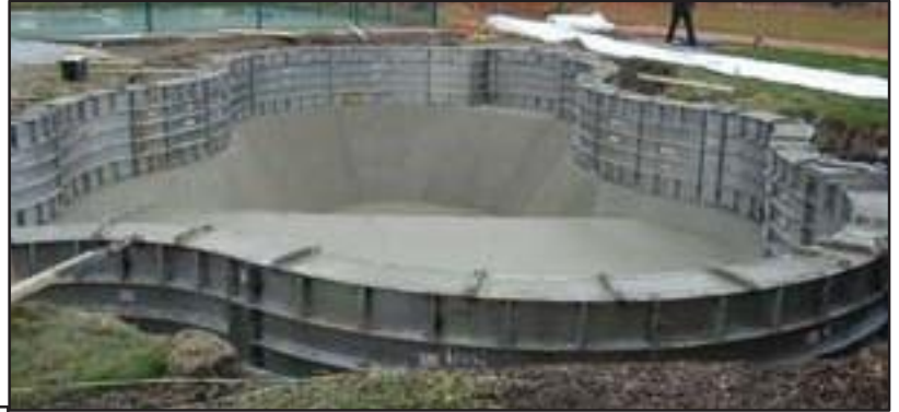
Piscine "Lago de Montaña" de 26' x 52' avec coulage monolithique
