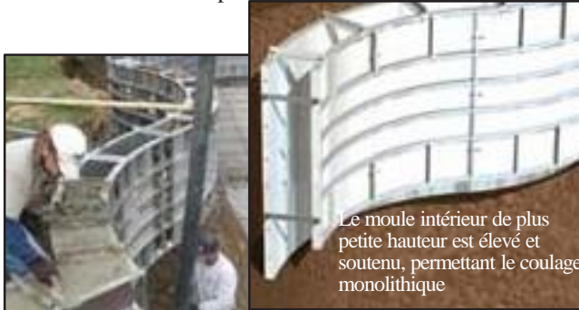
Piscine "Lago de Montaña" de 26' x 52' avec coulage monolithique
